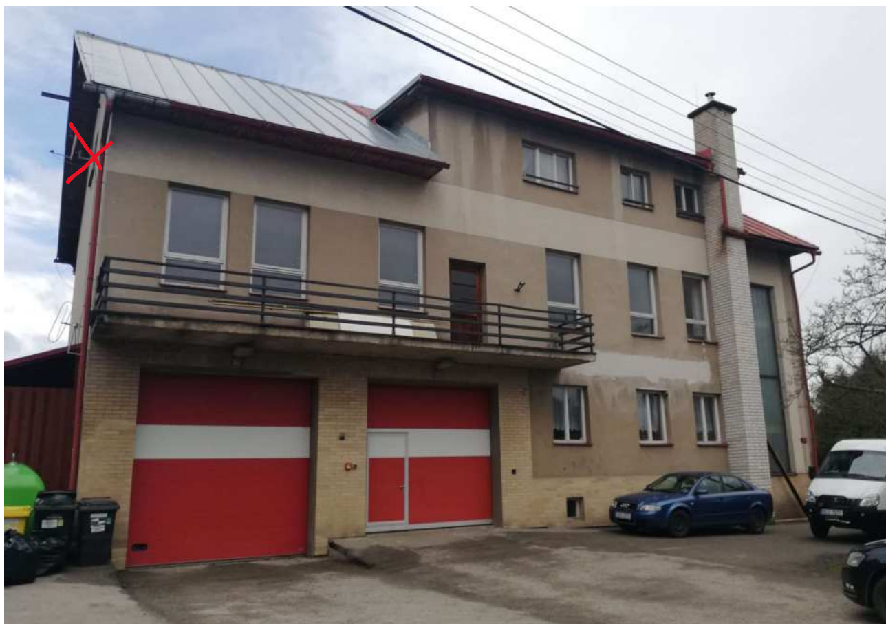
Čelní pohled (zaškrtnuté boční okno není součástí této zakázky), celkový počet sklepních oken v přední části – 3 ks
